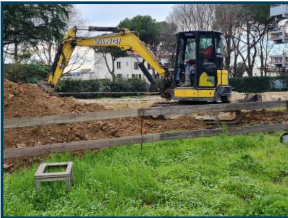
... il nuovo Nido Lo Stregatto in costruzione
