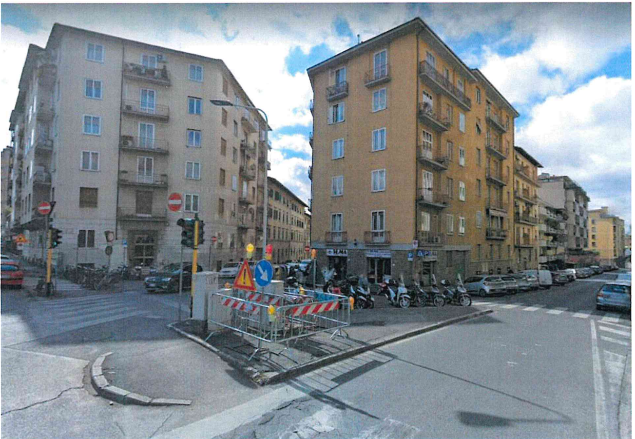
Viale Redi (incroci via Tozzetti via Ponte All'Asse)
